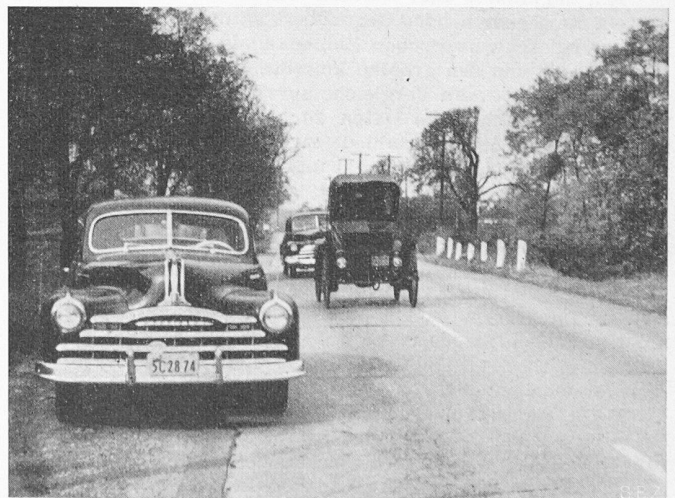
Bild 3. Beispiel einer normalen amerikanischen Ueberlandstrasse. Zwei Spuren zu 3 m, Beton, alte Ausführung (jetzt 3,6 m Breite). Durchwegs in Strassenmitte Leitlinien, beidseitig Abstellstreifen. Im Anrollen ein Auto aus dem Jahre 1902 mit luftgeköhltem Boxermotor und stufenlosem Getriebe mit Reibrad, auf einer Transkontinent-Reise begriffen.
