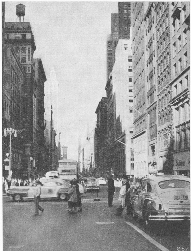
Bild 5. Kreuzung an der sechsspurigen Fifth Avenue, New York. Einfache Lichtsignalanlagen (vier Ständer mit je drei Lampen), während Spitzenzeiten durch Polizisten unterstützt. Die Zahl der Fussgänger ist in Manhattan derart gross, dass sie die Strasse überall kreuzen dürfen; nur auf Kreuzungen beschränkt, würden sie den Verkehr zu stark stören, deshalb fehlen Fussgängerstreifen
