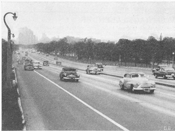
Bild 4. Outer drive, Chicago. Achtspurige, kreuzungsfreie Schnellverkehrsstrasse als nördliche Ausfallstrasse dem Michigansee entlang. Durch drei ferngesteuerte, versenkbare Trennungsbalken kann die Spurenzahl den Verkehrsbedürfnissen angepasst werden: morgens sechs stadtwärts, zwei auswärts, abends umgekehrt. In der Zwischenzeit nach beiden Richtungen vier Spuren, wie auf dem Bild, wo nur der mittlere Balken angehoben ist
