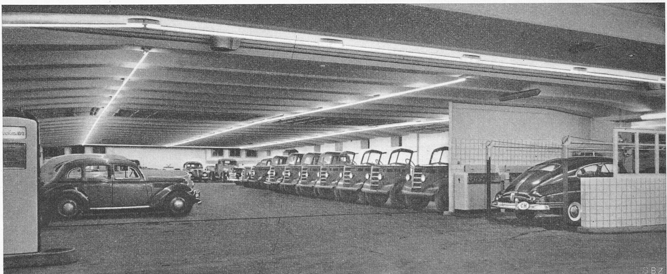
Bild 6. Die mittlere der drei je 17 m weit gespannten und 50 m langen Garagehallen
