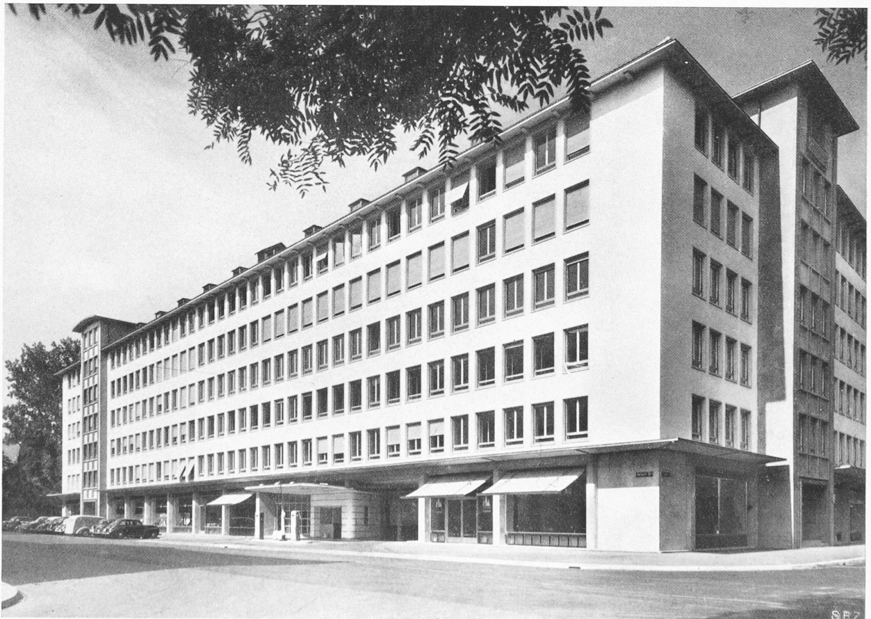
Fassade Gotthardstrasse, gegenüber der Tonhalle, mit Einfahrt zur Garage unter dem Hof
