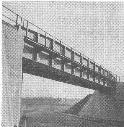
Eisenbahnbrücke über die Zufahrtstrasse zum Flughafen Kloten
