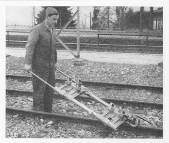
Bild 1. Verschieben des Leichtmetall-Stauchapparates (kleines Modell) auf dem Gleis
