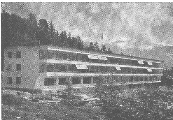
Sanatorium Valaisan Montana Raymond Wander, dipl. Architekt SIA, Zürich und Bern
