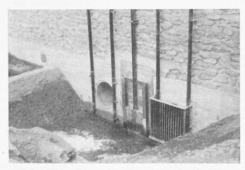
Bild 7. Die beiden Wasserfassungen am Fuss der Staumauer Nord, dazwischen der Grundablass
