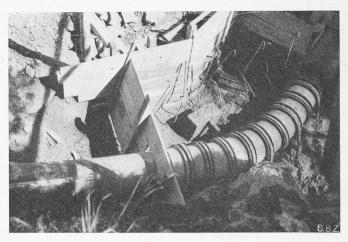
Bild 8. Fixpunkt 15 unmittelbar oberhalb der Zentrale
