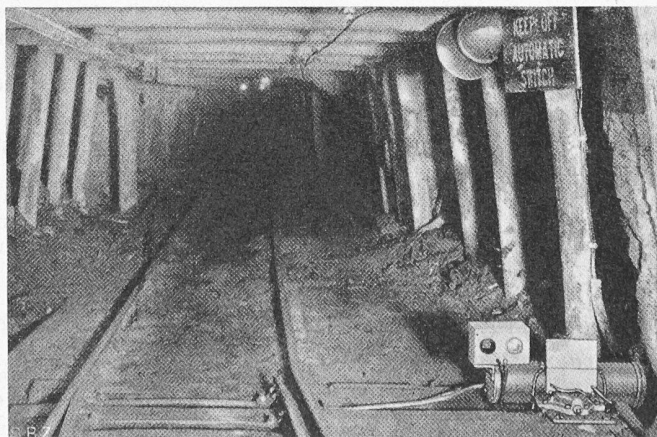
Bild 12. Elektrischer Weichenbock mit optischem Signal
