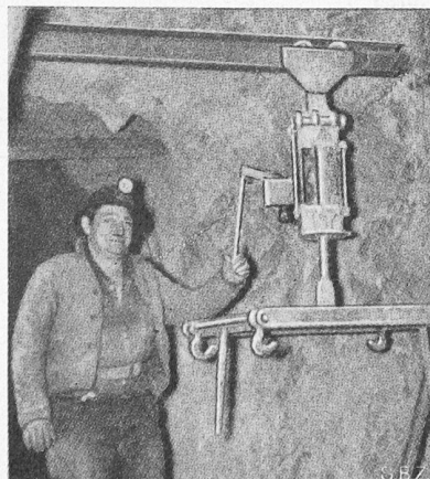
Bild 15. Laufkatze mit Druckluftzylinder
