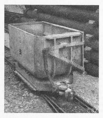
Bild 10. Rollwagen amerikanischer Konstruktion mit 2,0 m3 Inhalt
