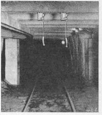
Bild 13. Kontakte zur Fernbedienung der elektrischen Weiche
