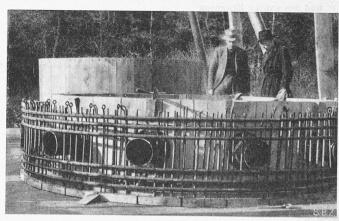
Bild 5. Brunnensegment mit Führungsrohren
