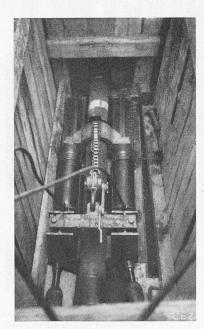
Bild 1. Horizontalbohr-Installation in gespriesstem Schacht
