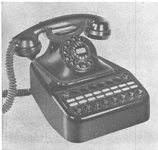
Hauszentrale für 1 Amtsleitung und 5 Teilnehmeranschlüsse
