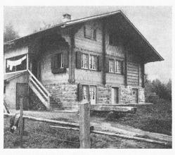
Bild 4. Das gleiche Haus nach dem Wiederaufbau. Die einfache Grundform wurde beibehalten. Der Stall ist nicht wie früher unter den Wohnräumen, sondern im rechten Teil des Hauses unter der Heubühne angeordnet
