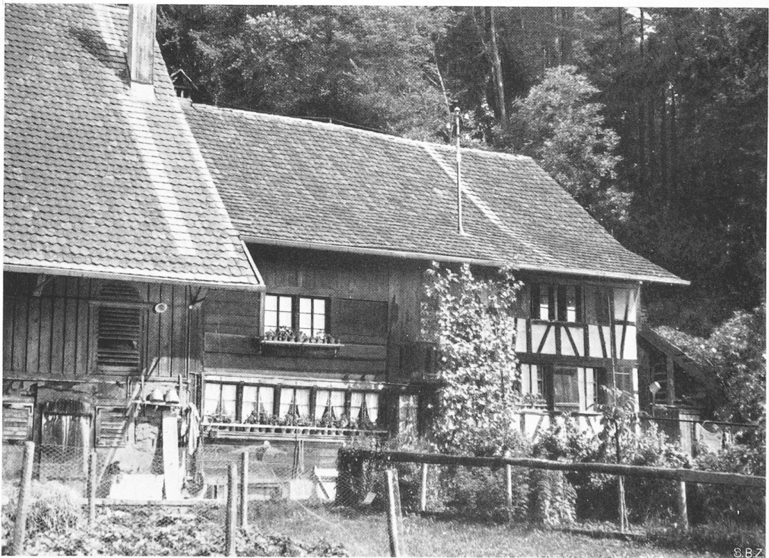
Schweikhof, Gemeinde Hausen am Albis. Kombiniertes Riegel- und Blockbau
