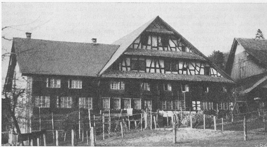
Bild 4. Bauernhaus im Ober-Albis. Wohnteil Blockbau, Giebel Riegelbau
