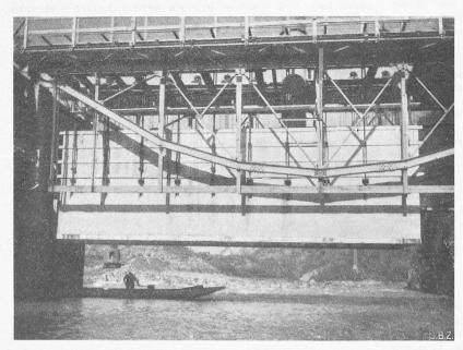
Bild 14. Schwellencaisson beim Absenken
