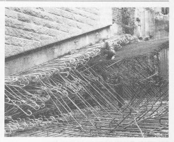
Bild 16. Blick in eine Schwellenbaugrube. Anschlussarmierung Pfeiler-Schwellenplatte
