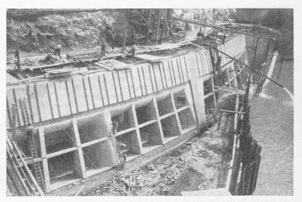
Bild 17. Wasserfassung, Baugrube für die Erstellung des Einlaufbauwerkes
