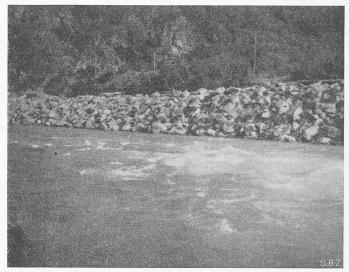
Blick 19. Rhonekorrektion. Sicherung der Ufer durch eine Blockschüttung mit der Neigung 2:3
