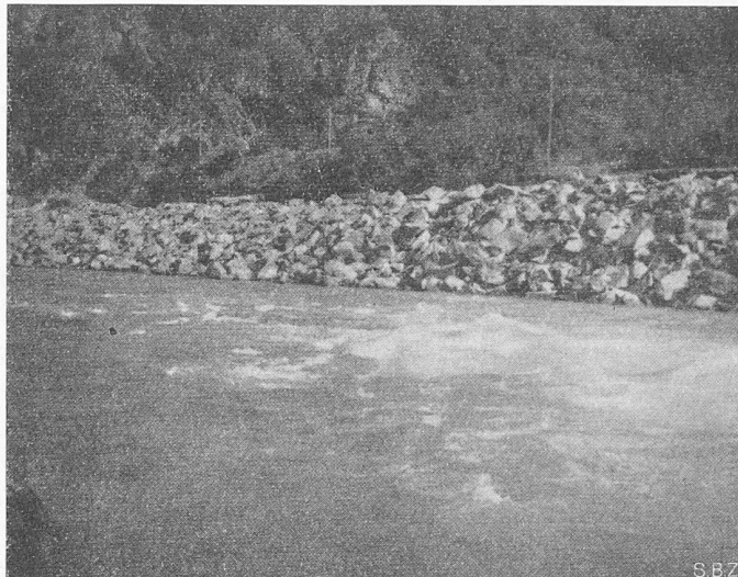
Blick 19. Rhonekorrektur. Sicherung des Ufers durch eine Blockschüttung mit der Neigung 2: 3
