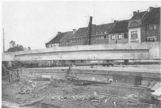
Fig. 5. Smets, poutres en dépôt
