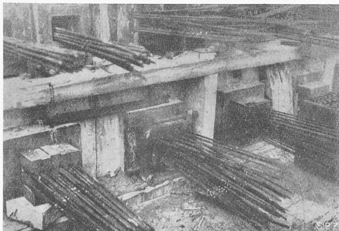
Fig. 4. Abouts des poutres avec câbles
