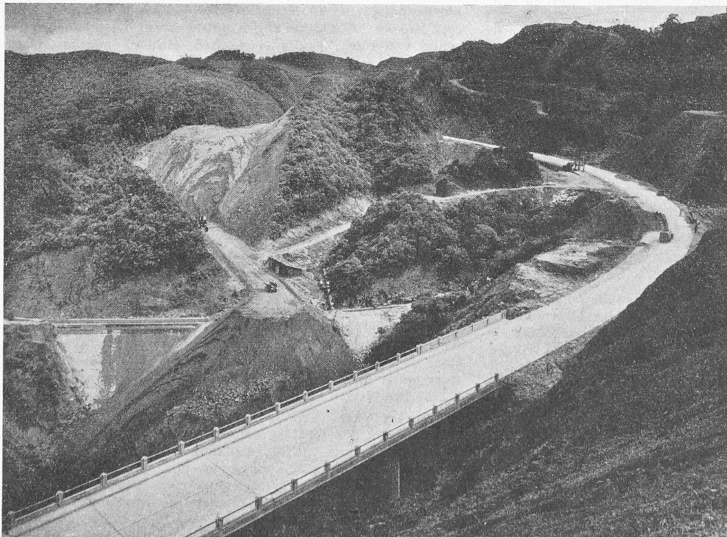
Die Via Anchieta in der Bergstrecke; eine Spur fast vollendet, die andere im Bau. Cliché «Technique des Travaux», Lüttich
