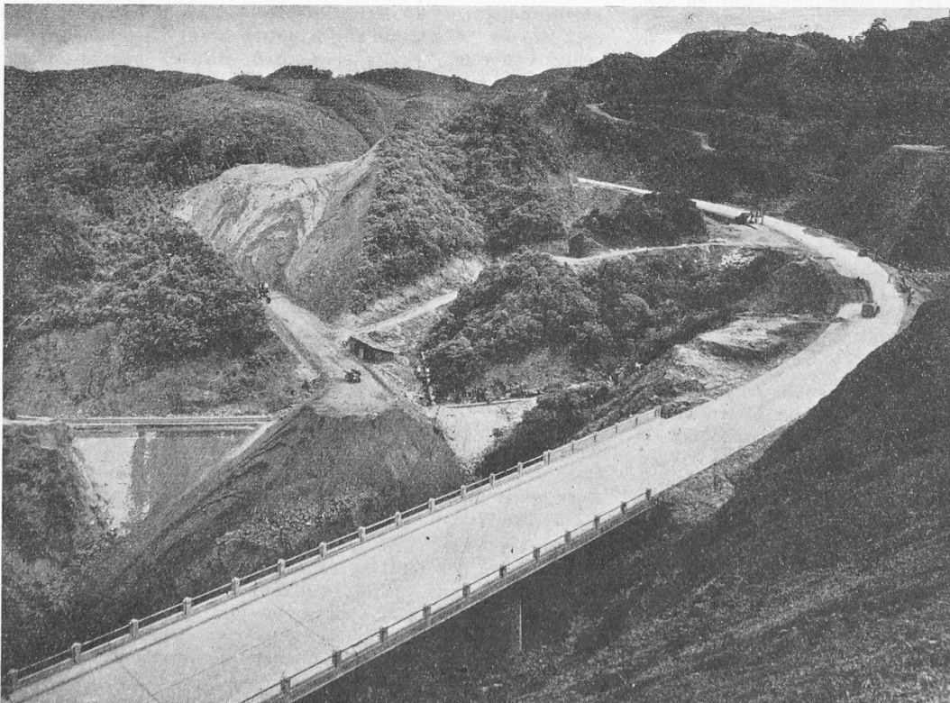
Die Via Anchieta in der Bergstrecke; eine Spur fast vollendet, die andere im Bau. Cliché «Technique des Travaux», Lüttich
