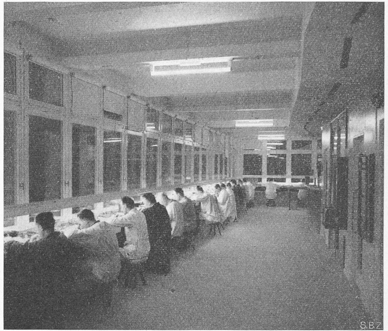
Bild 2. Spezialbeleuchtung in einer Uhrenfabrik mit aufwindbaren Leuchten in Einheiten von vier bis sechs Längen, bestückt mit Fluoreszenzlampen TL 40 Watt. Mittlere Beleuchtungsstärke auf den Arbeitsplätzen 1000 bis 2000 Lux. Am Tag werden die Leuchten an die Decken hochgezogen
