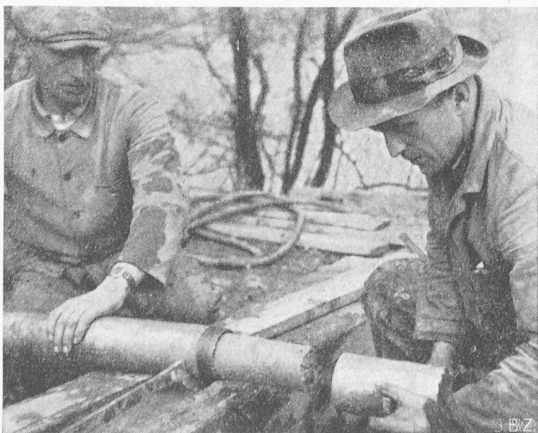
Bild 5. Herausnehmen eines Kernes von Molassemergel aus dem Kernrohr der Craelius-Rotationsmaschine AB 2
