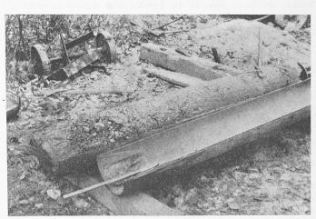
Bild 4. Mit dem Bohrpfahl erhaltener Kern aus Kies und Sand vor Herausnahme aus dem geöffneten Kernrohr (Bohrung 15)
