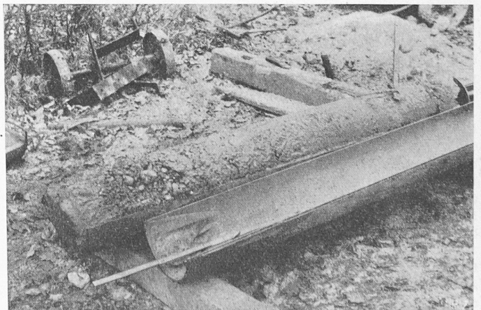
Bild 4. Mit dem Bohrpfahl erhaltener Kern aus Kies und Sand vor Herausnahme aus dem geöffneten Kernrohr (Bohrung 15)
