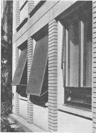
Bild 17. Rolladen System AKZ, ohne Oeffnen des Fensters beliebig ausstellbar
