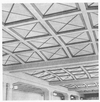
Bild 13. Schallschluckende Deckenfüllungen (Pavatex mit
