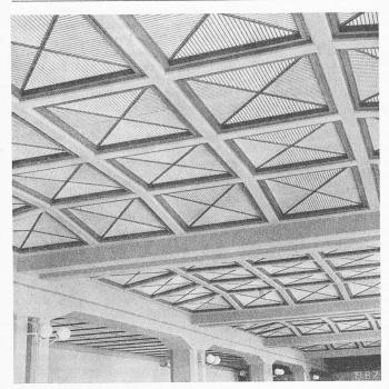
Bild 13. Schallschluckende Deckenfüllungen (Pavatex mit
