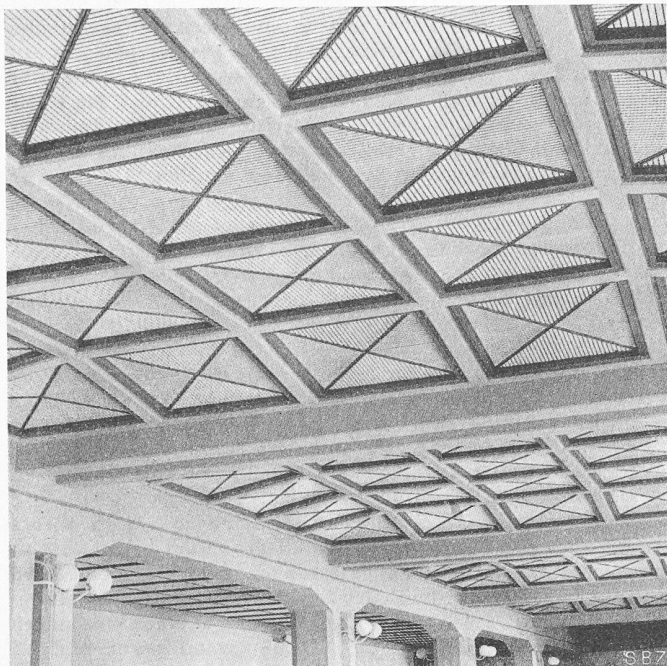
Bild 13. Schallschluckende Deckenfüllungen (Pavatex mit Naturholzrahmen)
