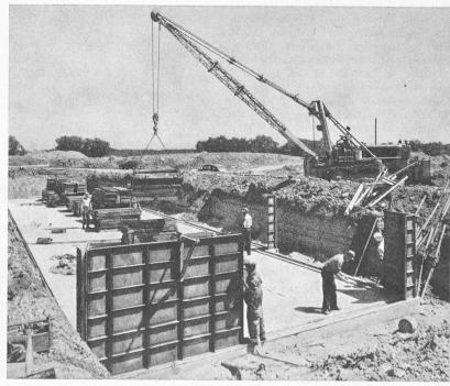
Bild 3. Versetzen der Schaltafeln für die Kellerwände
