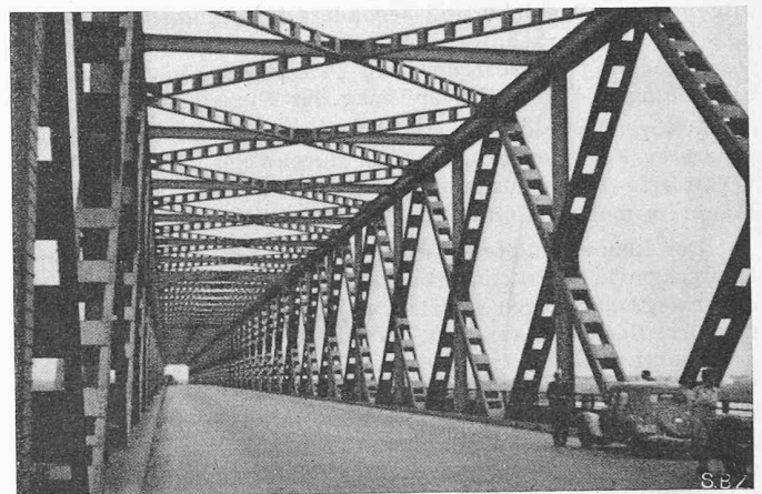
Bild 14. Maasbrücke bei Moerdijk
