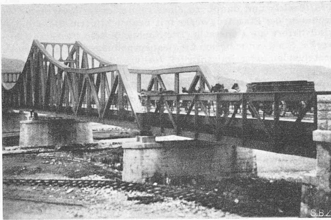
Bild 12. Obere Rheinbrücke bei Diepoldsau
