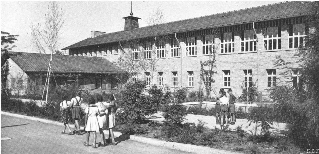
Flügel an der Balberstrasse aus Südwesten, links Hauswart-Wohnung
