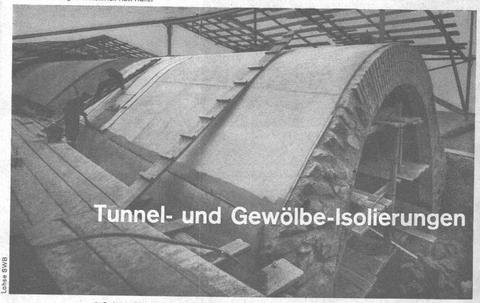
2. Geleise SBB Brunnen-Sisikon mit teerfreier, elastischer Bitumen-Gewebeplatte ASPHALTOID
