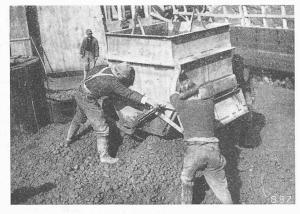
Bild 18. Entleeren des Kübels
