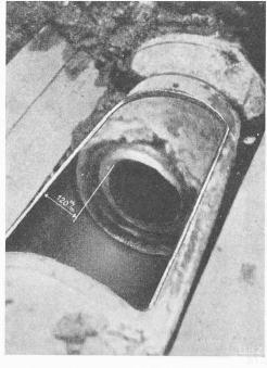
Bild 7. Rohrleitung des Elektrizitätswerkes Schwarzsee (Kt. Fryburg), von ursprünglich 450 mm l. W., mit Oeffnung zum Entfernen des weggefrästen Materials. Unten das gereinigte
