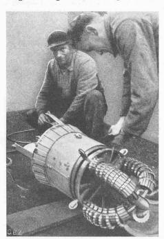
Bild 6. Bereitstellen der Maschine Bild 5 im Wasserschloss einer Druckleitung: Zentrieren und Einstellen der Fräsvorrichtung auf den Rohrdurchmesser
