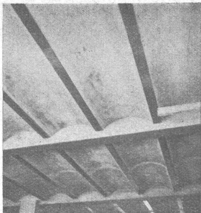
Fabrikdecke ausgeschalt
