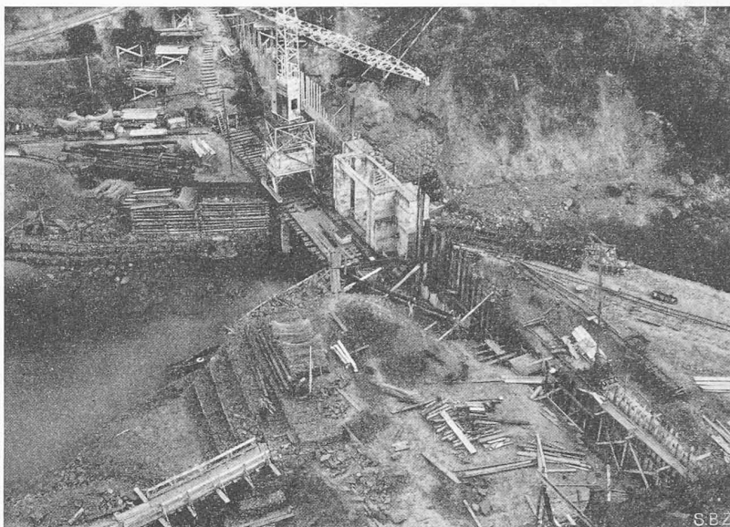
Bild 4. Bau des Schutzdammes mit abschliessbarem Durchfluss für die Saane
