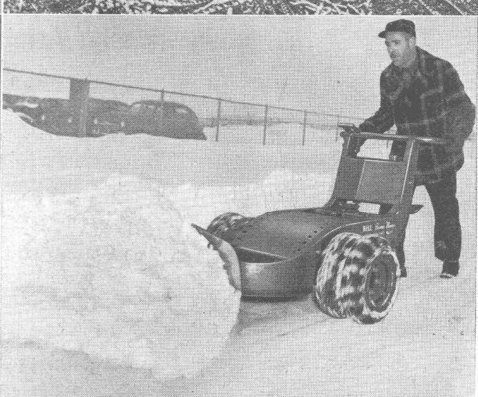
Ueberall dort, wo eine Handkarrette oder ein Stosswagen verwendet wird, kann der neue motorisierte BELL Stossskarren eingesetzt werden. Er transportiert mühelos Lasten von 450 bis 500 kg, wobei er Steigungen bis zu 20% überwindet. Die Ersparnis beträgt
