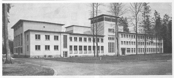
Bild 30. Windkanal der Kriegstechn. Abteilung in Emmen, Ansicht der Gesamtanlage von Südosten. Links Maschinensäle, anschliessend kleiner Windkanal, dahinter grosse Messhalle, rechts Trudelturm und Bureaugebäude
