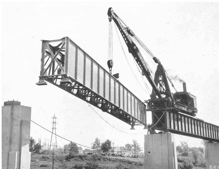
Bild 1. Aufstellung eines 30 m langen Blechbalkens aus Aluminium
