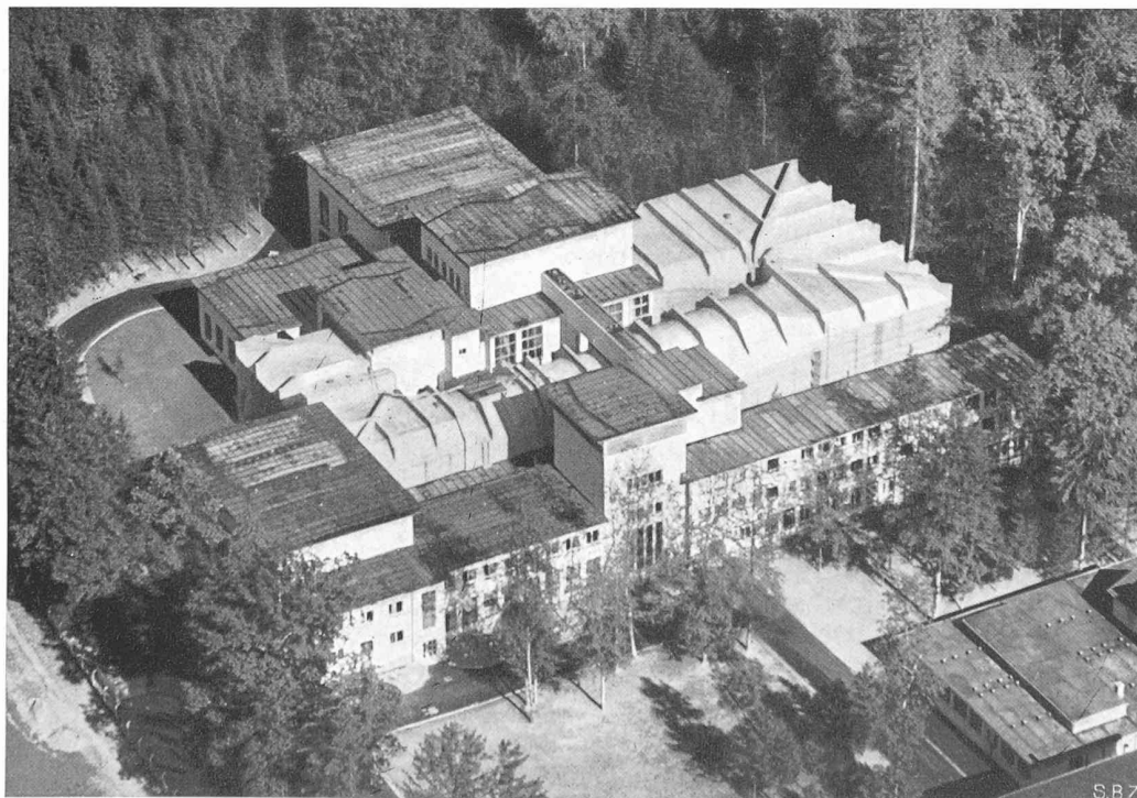
Bild 1. Fliegerbild der Gesamtanlage, vorn links Maschinenhalle, Mitte kleine Messhalle mit Trudelturm, rechts Bureaugebäude, dahinter grosser Windkanal und Messhalle. Phot. Militärflugdienst
