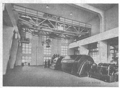
Laufkran 75/10 t, Spannweite 12,95 m Helsinki - Finnland
