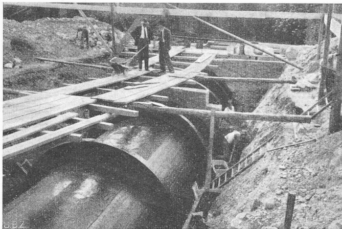
Bild 13. Schalengewölbe in Arlesheim. Fertig vor dem Eindecken
