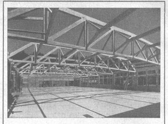
Eisenbetonfachwerk - Montagefertig
