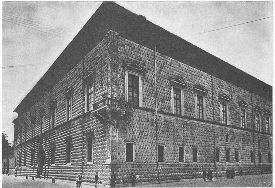
Ferrara, Palazzo dei Diamanti (Inneres schwer beschädigt)
