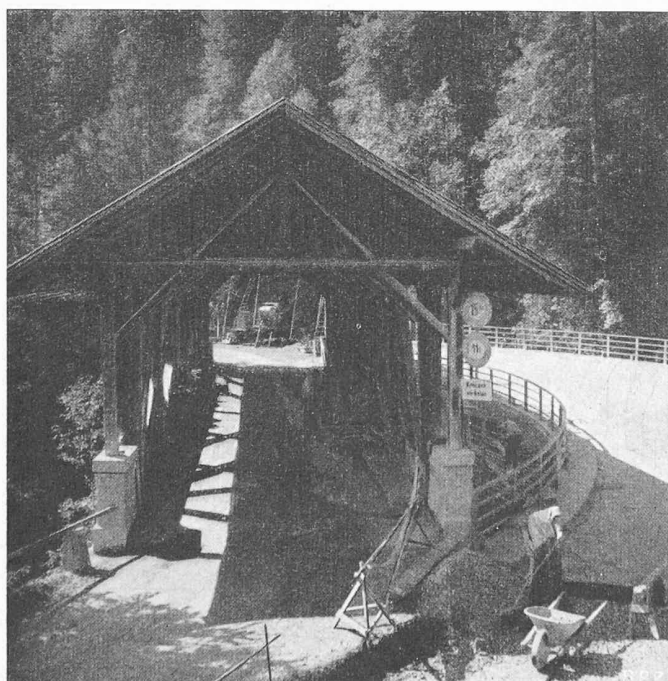
Bild 3. Alte Holzbrücke im Marchgraben
