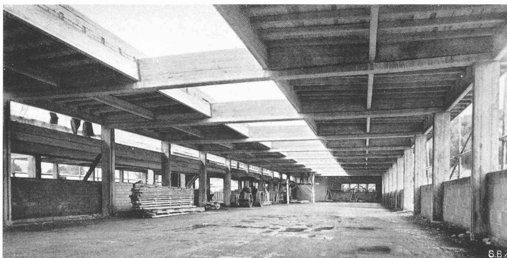
Werkstätten-Halle 14×82 m mit Bindern und Pfetten aus Spannbeton
