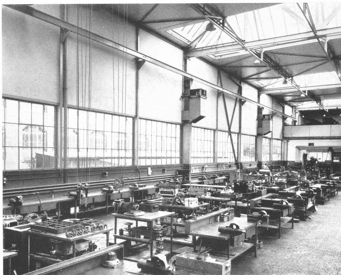
Automobil-Reparaturwerkstätte, seitliche Zone
