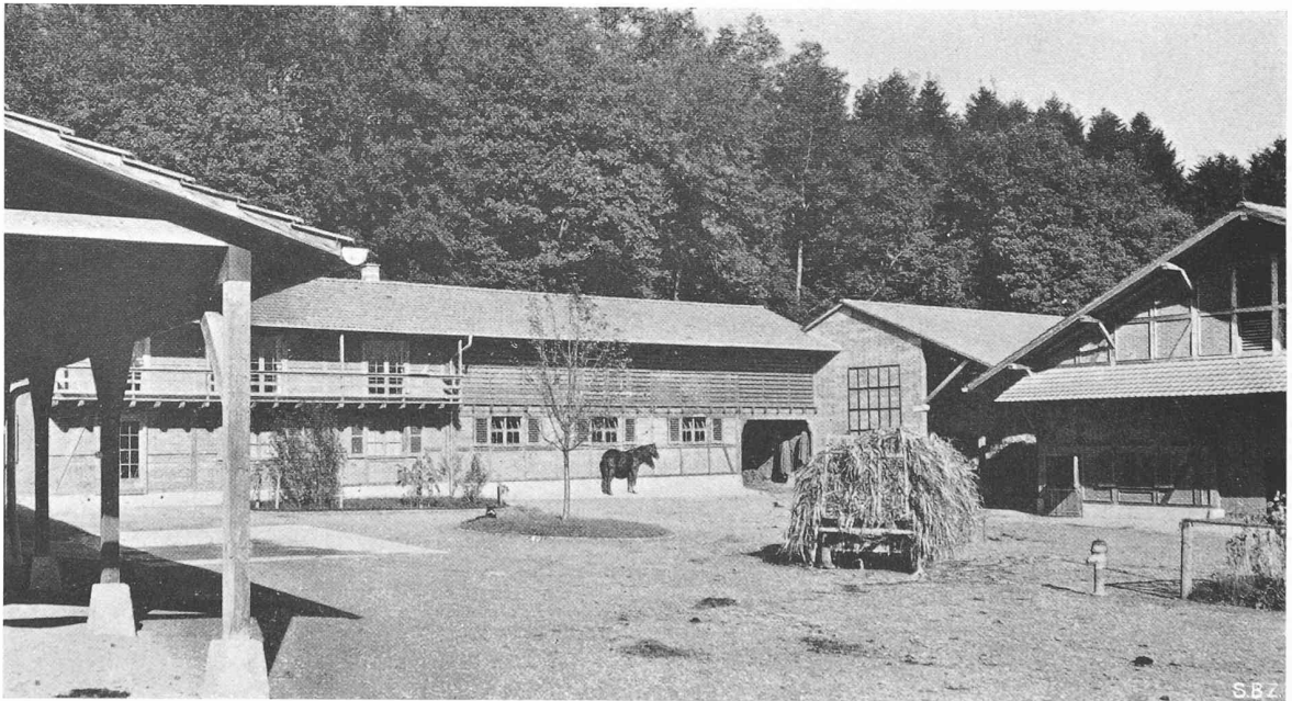
Der Hof mit Zöglingsbau und Pferdestall sowie Getreideschopf, rechts Rindviehstall
