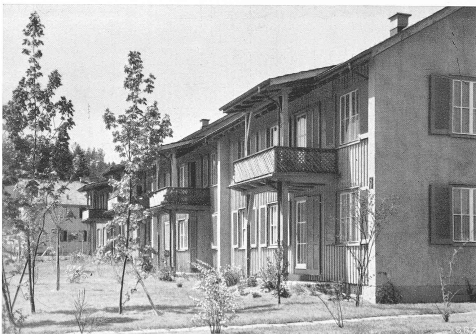
Bild 5. Einzelheiten der Holzbauweise (Stirnwände und Brandmauern massiv)
