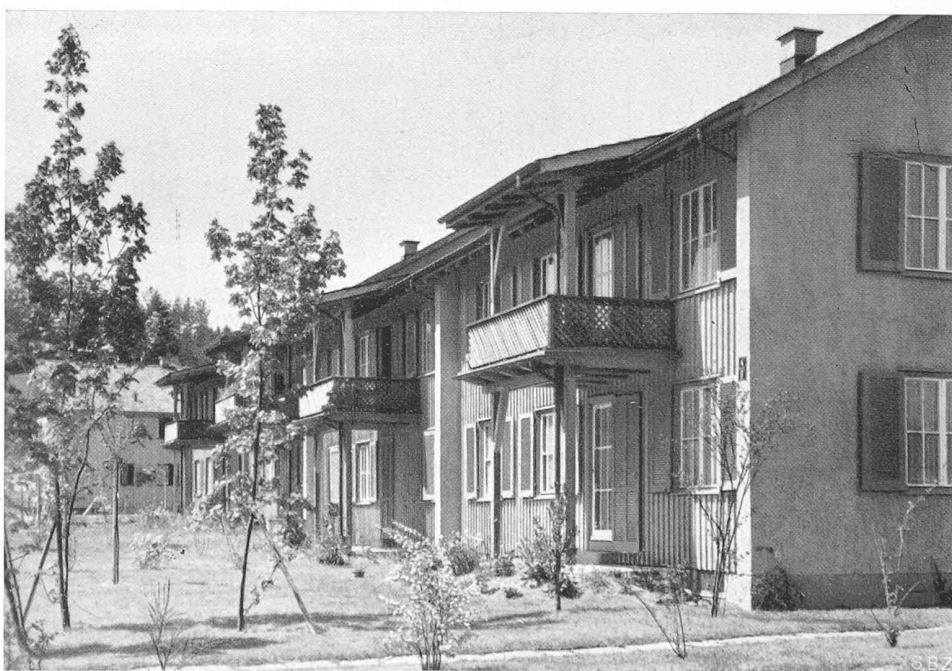
Bild 5. Einzelheiten der Holzbauweise (Stirnwände und Brandmauern massiv)
