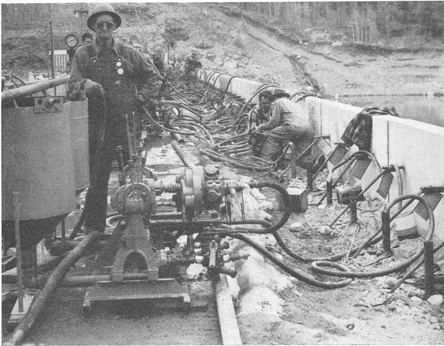
Bild 5. Mauerkrone während des Einfüllens des Mörtels. Links Zwischenbehälter für Mörtel, darüber Mörtelzubringerleitung, daneben Mörtelpumpe mit Druckluftmotor für den Antrieb, darunter Anschlussstutzen für die Schläuche. Rechts: Enden der vertikalen 2" Mörtel-Einfüllrohre mit hineingesteckten Schläuchen, dazwischen Inspektionsrohre
