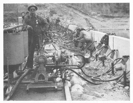
Bild 5. Mauerkrone während des Einfüllens des Mörtels. Links Zwischenbehälter für Mörtel, darüber Mörtelzubringerleitung, daneben Mörtelpumpe mit Druckluftmotor für den Antrieb, darunter Anschlusstutzen für die Schläuche. Rechts: Enden der vertikalen 2" Mörtel-Einfüllrohre mit hineingesteckten Schläuchen, dazwischen Inspektionsrohre
