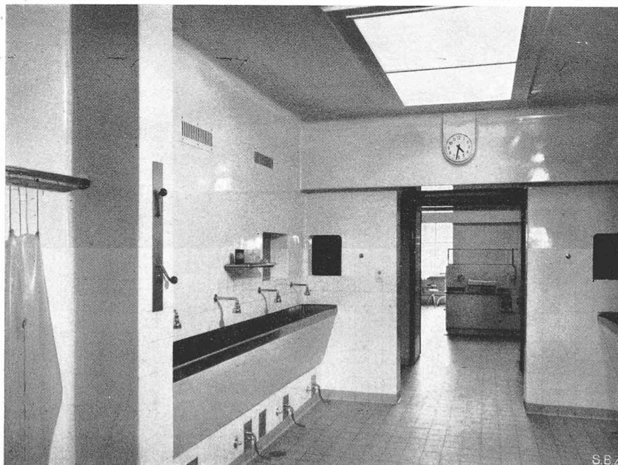
Salle de préparation des chirurgiens; à gauche et à droite les guichets d'observation pour les salles d'anesthésie et d'opération
