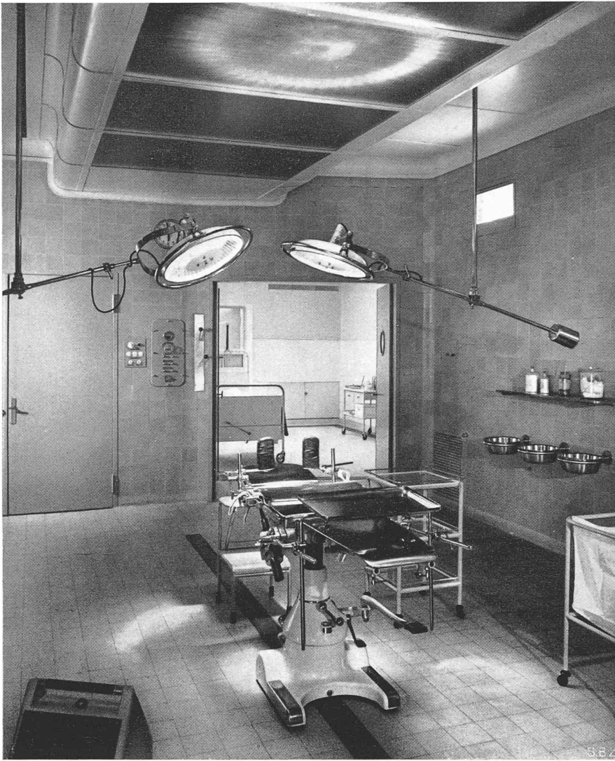
Salle d'opération II vers la salle de pansements. Entre les portes tableaux de commande éclairage, ventilation, obscurcissement
