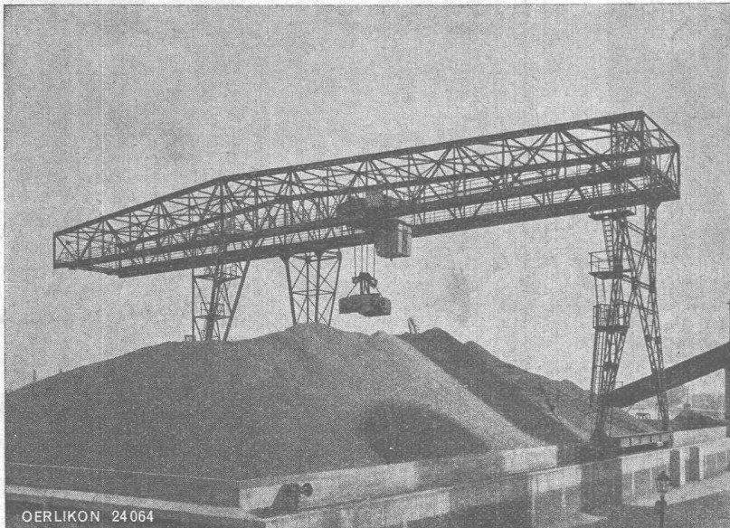
Verladebrücke mit Greiferlaufkatze für Kohlenlager Bruttolast 4,2 t, Ausladung 18,5 m, Spannweite 28 m
