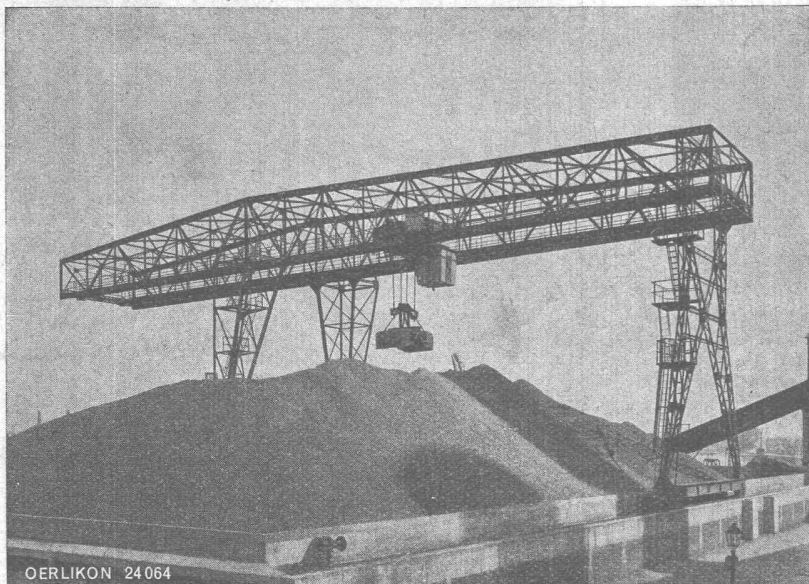
Verladebrücke mit Greiferlaufkatze für Kohlenlager Bruttolast 4,2 t, Ausladung 18,5 m, Spannweite 28 m
