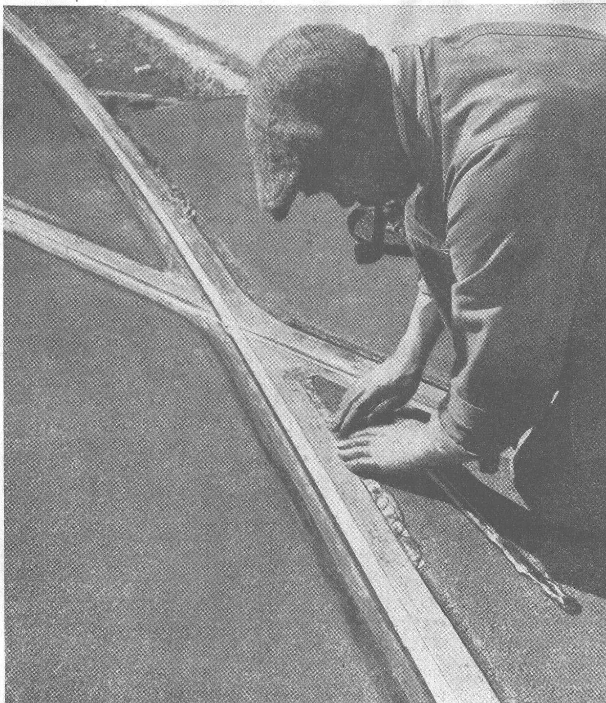
Umbau Bahnhofplatz Zürich, Einbauen von Fugenkitt-Paltox zwischen Tramgeleise und Strassenbelag
