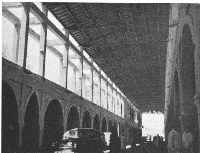
Bild 9. Eisenbetonkonstruktion einer neuen Basarstrasse in Jeddah
