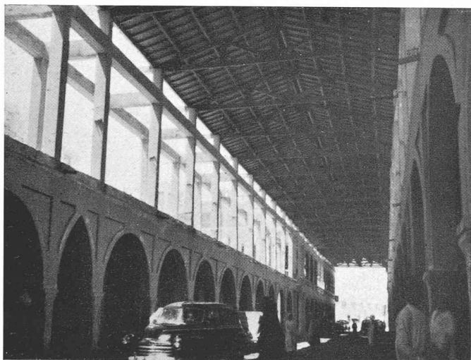
Bild 9. Eisenbetonkonstruktion einer neuen Basarstrasse in Jeddah
