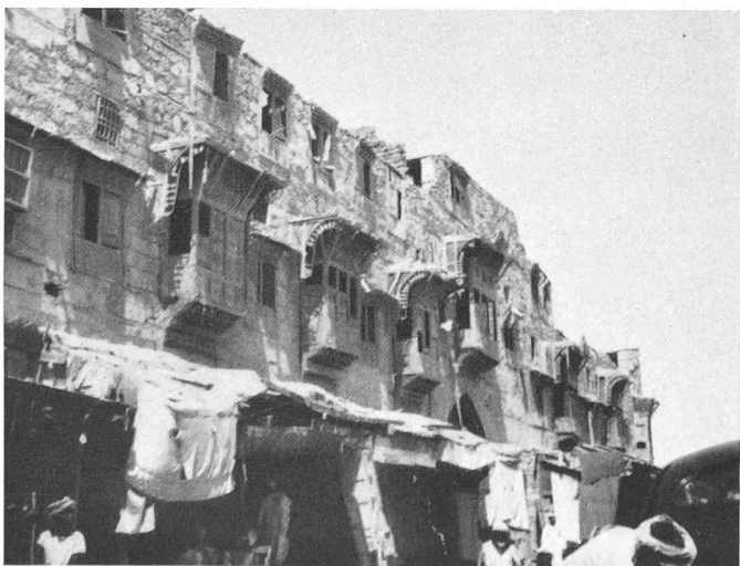
Bild 5. Gebäude in der Nähe des Basars: im Erdgeschoss Verkaufsbuden, oberstes Geschoss eingestürzt
