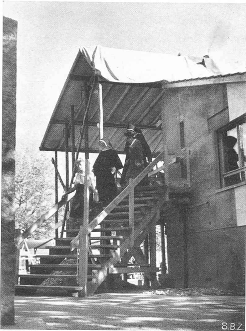
Bild 7. Musterhaus in Gruppe «Baugewerbe». Hausecke angeschnitten, alle interessanten Konstruktions-Einzelheiten werden sichtbar. Erster Drittel Rohbau, dann Innenausbau und fertige Räume
