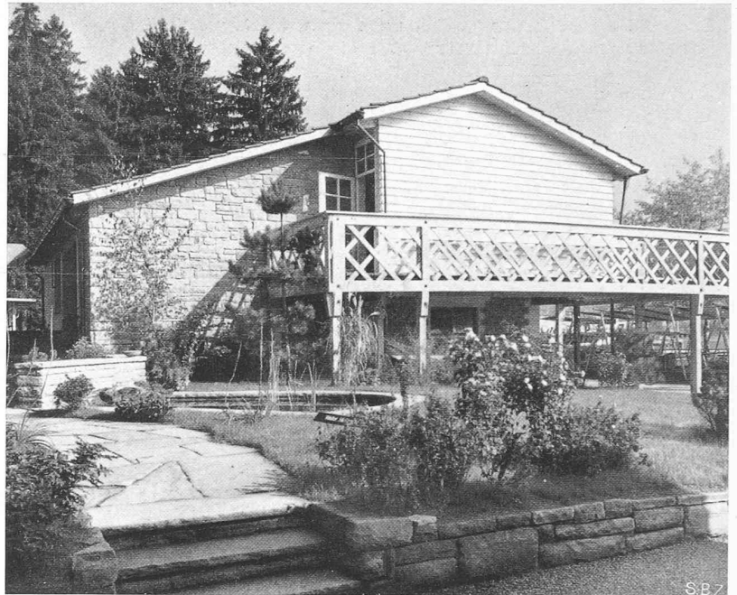
Bild 8. Musterhaus (Pläne u. Ausführung Alfred Altherr, Arch. BSA). Fertig erstellter Gebäudeteil; Brüstung des Besucherganges als tragendes Element (Ing. H. Lechner, Zürich)
