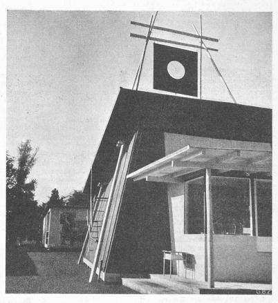
Bild 11. Ausstellungs-Kino. Vorführungskabine verglast. Die bock-artigen Rundholzstreben tragen die Dachscheibe und das Signet; die Seitenwände (diagonal verschalte selbständige Scheiben) im Sinne eines Kartenhauses schräg zusammengestellt. Im Hintergrund Halle «Bekleidungsgewerbe» mit Wandbild von Karl Hosch
