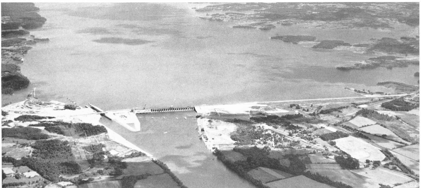
Bild 7. Kraftwerk Kentucky. Als Masstab: Länge des Stauwehres (24 Schützenöffnungen) 356 m, des anschliessenden Erddammes 1800 m
