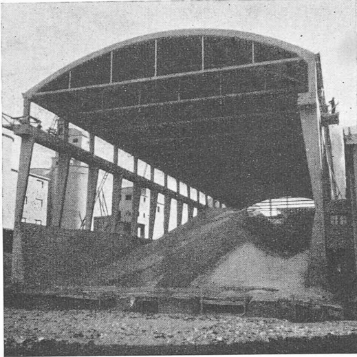
Bild 1. Klinkerhalle von Westen
