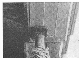
Bild 2. Randbalken, \frac{1}{3} der Verschiebung bereits behoben
