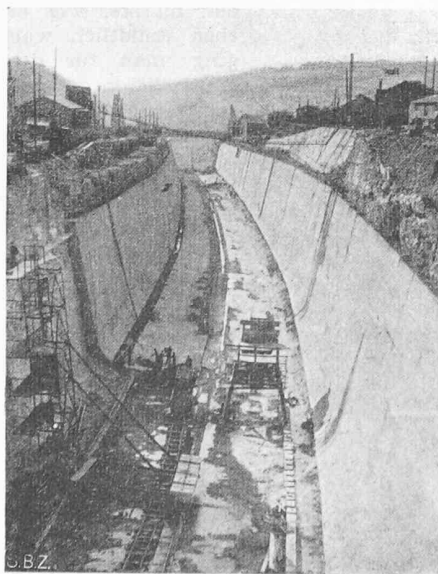
Bild 6. Abflussgraben 12 am 11. Okt. 1947
